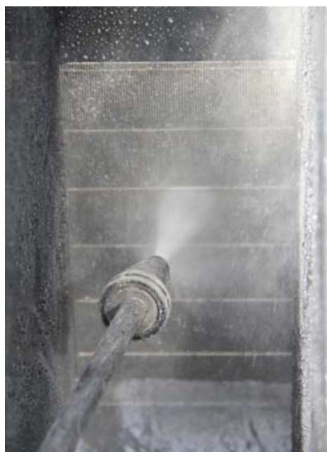
Obr. 29: Čištění síta pomocí vysokotlakého čističe
